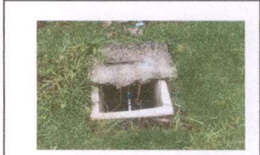
Foto 8: SUSTITUCION DE CAJA DE REGISTRO
