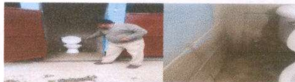
Foto 6: SUSTITUCION DE INODORO
