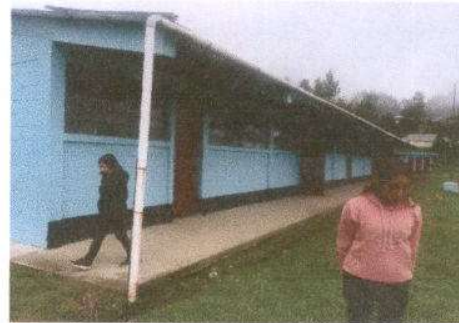
Foto 4: SUSTITUCION DE CANAL PVC
