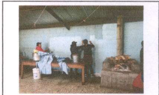
Foto 12: REPARACION DE CHIMENEA DE CONCRETO Y SUSTITUCION DE LAVATRASTOS
