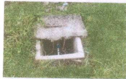
Foto 8: SUSTITUCION DE CAJA DE REGISTRO
