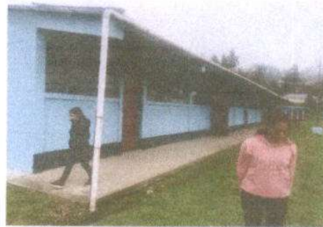
Foto 4: SUSTITUCION DE CANAL PVC
