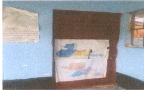
Foto 2: SUSTITUCION DE PUERTA DE MADERA POR METAL
