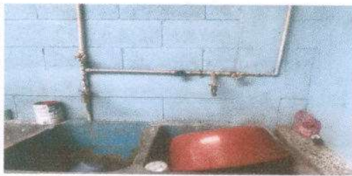
Foto 9: SUSTITUCION DE TUBERIA LINEA PRINCIPAL RED DE AGUA POTABLE
