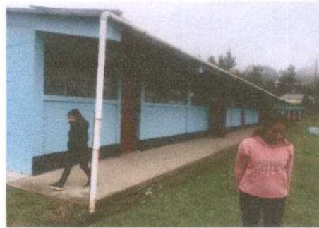
Foto 4: SUSTITUCION DE CANAL PVC
