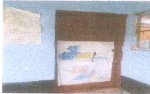
Foto 2: SUSTITUCION DE PUERTA DE MADERA POR METAL
