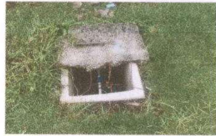
Foto 8: SUSTITUCION DE CAJA DE REGISTRO
