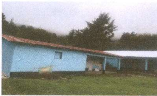
Foto 1: SUSTITUCION DE LAMINA, POR LAMINA TROQUELADA ALUZINC CALIBRE 26
