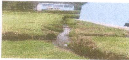
Foto 7: SUSTITUCION DE TUBERIA PVC LINEA PRINCIPAL AGUAS NEGRAS 3"
