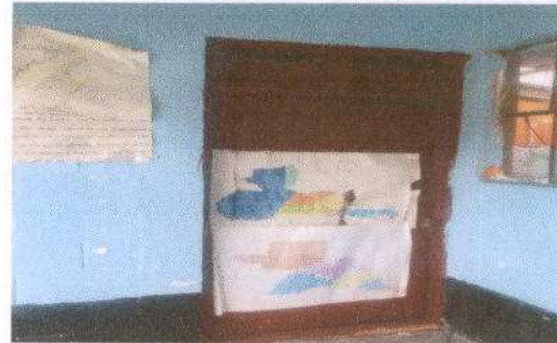
Foto 2: SUSTITUCION DE PUERTA DE MADERA POR METAL
