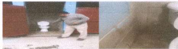
Foto 6: SUSTITUCION DE INODORO
