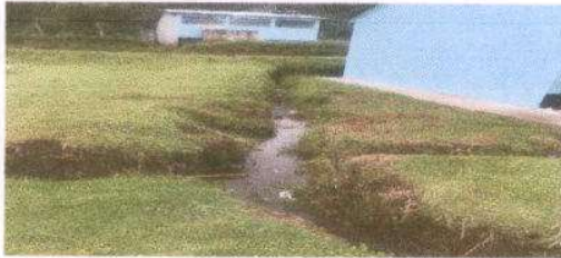
Foto 7: SUSTITUCION DE TUBERIA PVC LINEA PRINCIPAL AGUAS NEGRAS 3"
