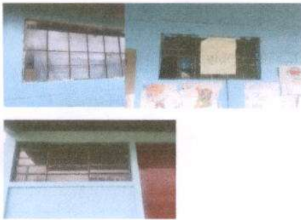
Foto 3: SUSTITUCION DE VENTANAS DE MADERA POR METAL MAS VIDRIO
